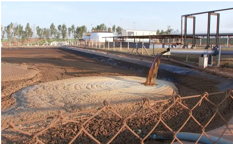
Figura 10: Tanque de tratamento de vinhaça ou vinhoto
